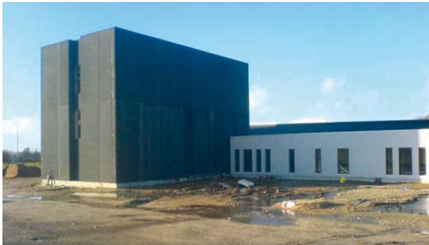
Håndværkerne arbejdede i december på højtryk for at få lokalerne færdige til den planlagte åbning i januar.
